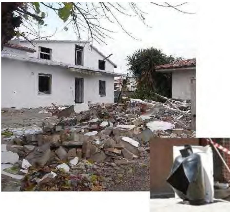
Figura 73. Cantiere edile, esplosione bombola gas.
